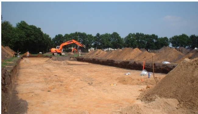
Afb. 1. Een sleuf van 10 bij 50 meter werd gegraven
