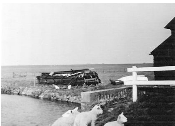
Afb. 3. Het spoorlijntje is gesloopt en de rails liggen netjes opgestapeld. Ze zijn voor oud ijzer van de hand gedaan.
